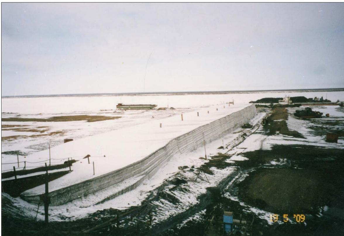
Фото 3.9. Речной флот п. Хатанги спрятан от ледохода за ледяной дамбой. Фото П.М. Карягина. Температура воды у берега поднялась до  $+0.5^{\circ}$ , воздуха до  $10^{\circ}$ . В реке появилось течение и с этого момента начался процесс размывания дамбы на уровне контакта ее с водным потоком.
